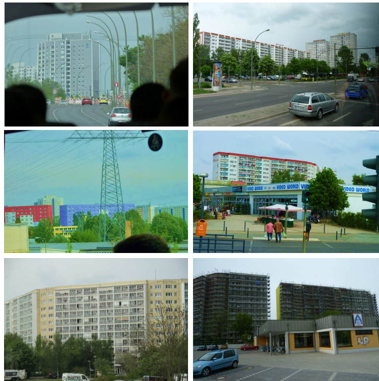
Impressionen der Marzahner Plattenbauten, die auch die zum Teil schon renovierten oder derzeit in Renovierung befindlichen Wohnblocks von Marzahn zeigen (s.u.).
